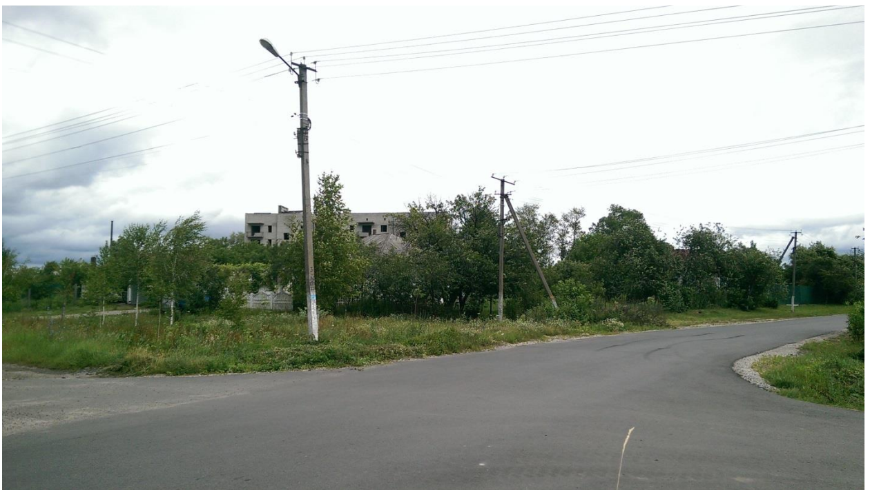
Недобудований п'ятиповерховий будинок по вулиці Н.Сіверська,11 смт. Вороніж Шосткинського району Сумської області
